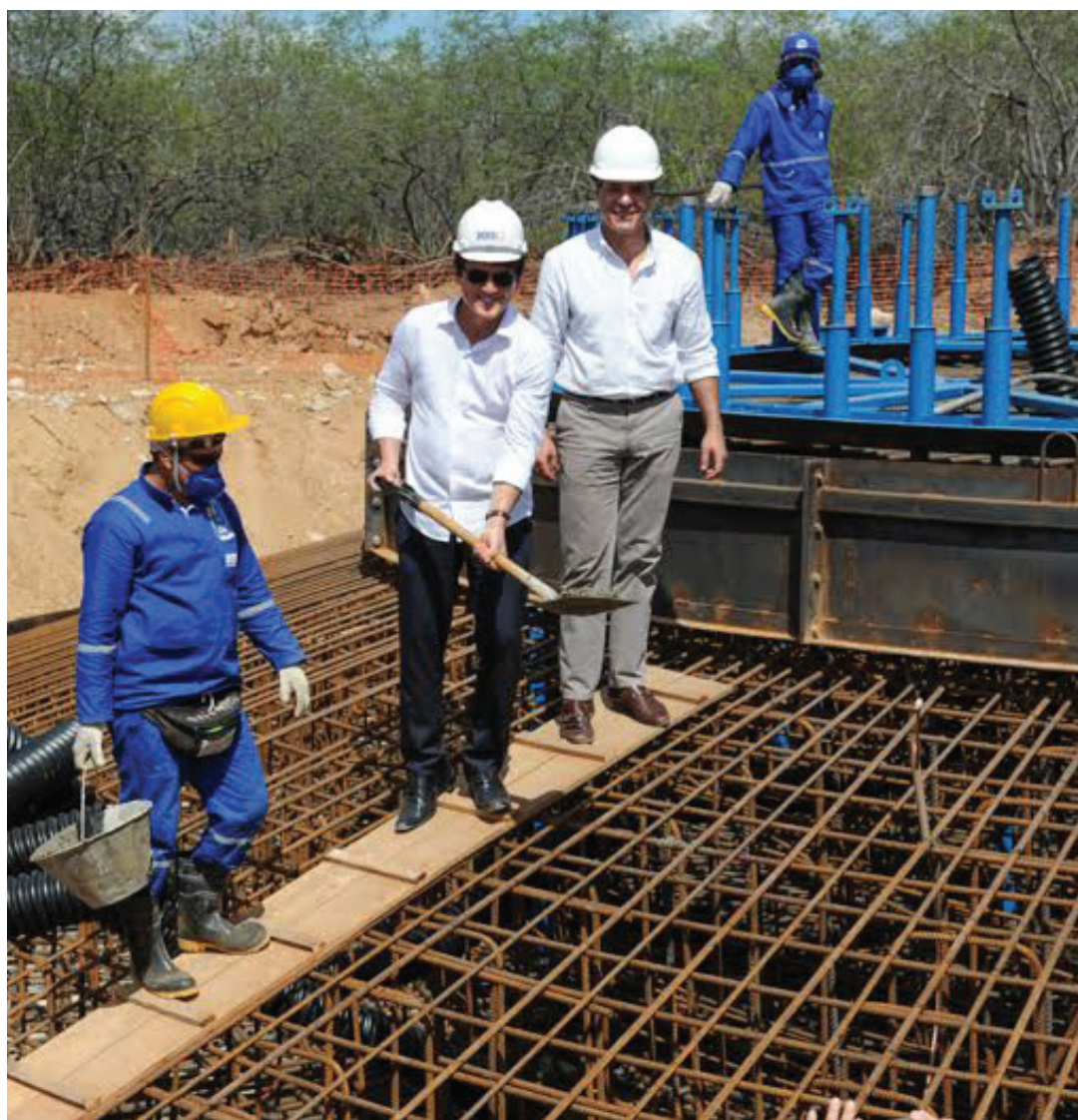
Governador deu início à construção do Complexo Eólico Cutia: empreendimento representa investimento de R$ 1,6 bilhão
